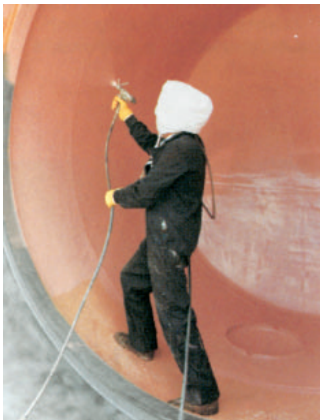
Pulvérisation de résine époxy à l'intérieur d'un réservoir.
